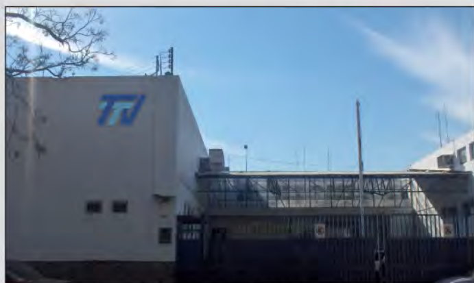
FÁBRICA TTV MÉXICO TTV PLANT MEXICO ЗАВОД ТТВ МЕКСИКА
